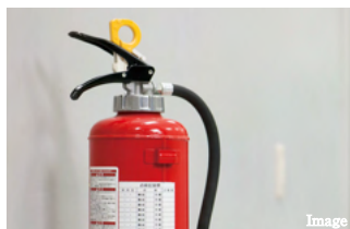
各階に消火器設置
